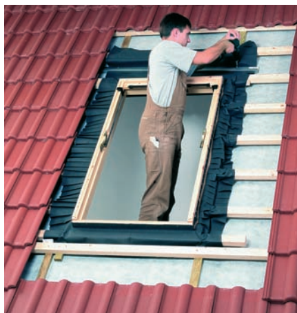
BDX 2000 се състои от термоизолационна рамка и хидроизолационна пола
